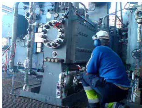
Aby wykryć wyciek gazu, należy skierować detektor dokładnie w kierunku jego lokalizacji. Kamery do optycznego obrazowania gazów potrafią wykrywać wycieki gazów w dowolnym miejscu znajdującym się w ich polu widzenia.
