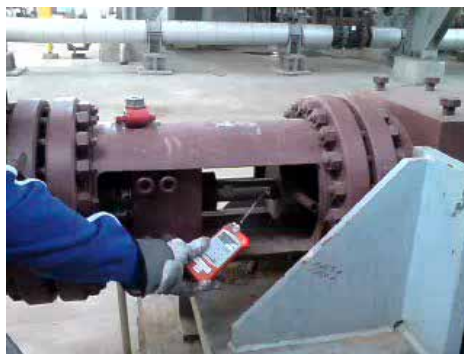
Niewielki wyciek gazu wykryty za pomocą kamery do optycznego obrazowania gazów jest mierzony przy użyciu detektora. Ponieważ stężenie znajduje się poniżej wartości progowej, ten wyciek nie ma wysokiego priorytetu.
