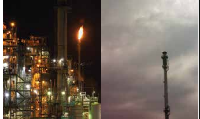
Diverses technologies sont utilisées pour contrôler les torchères, mais leurs performances sont limitées pour regarder au travers de la fumée.
